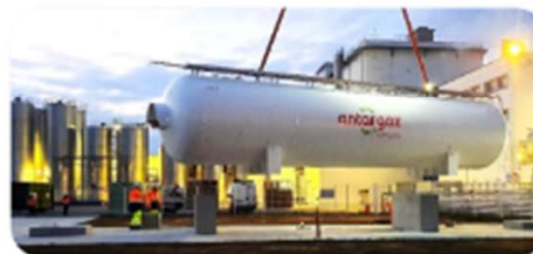
Mise en place d'un réservoir de 100 m 3 à Montauban
