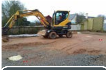
Les travaux ont démarré en décembre 2023 et devraient s'achever à l'été 2024.
